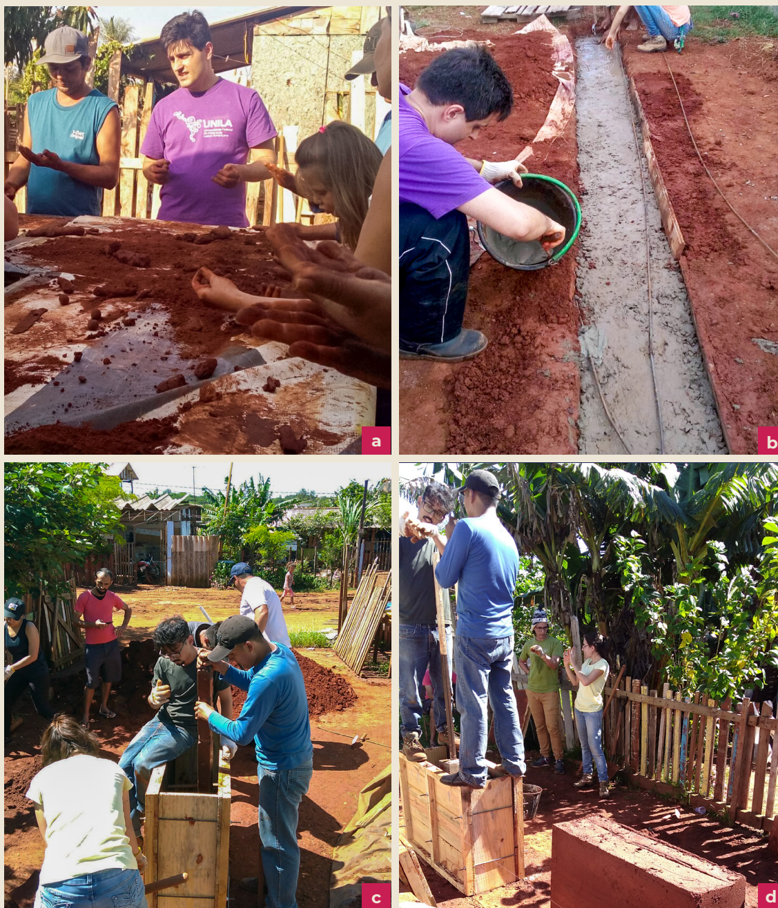
Figura 6: Etapas do minicurso: reconhecimento do solo (a), fundação (b), compactação (c) e desmolde (d). Fonte: autor, 2017.
