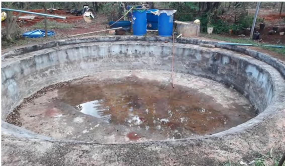
**Figura 2.** Reservatório da Parcela 16 - tanque escavado e revestido em ferrocimento Foto de Acácio Machado, 2020
