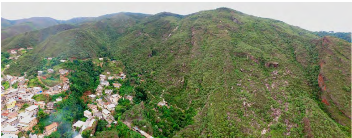
Figura 6: Vista aérea do setor de desmonte hidráulico na Serra do Veloso, localizado no município de Ouro Preto. Fonte: Eduardo Evangelista Ferreira (2017).
