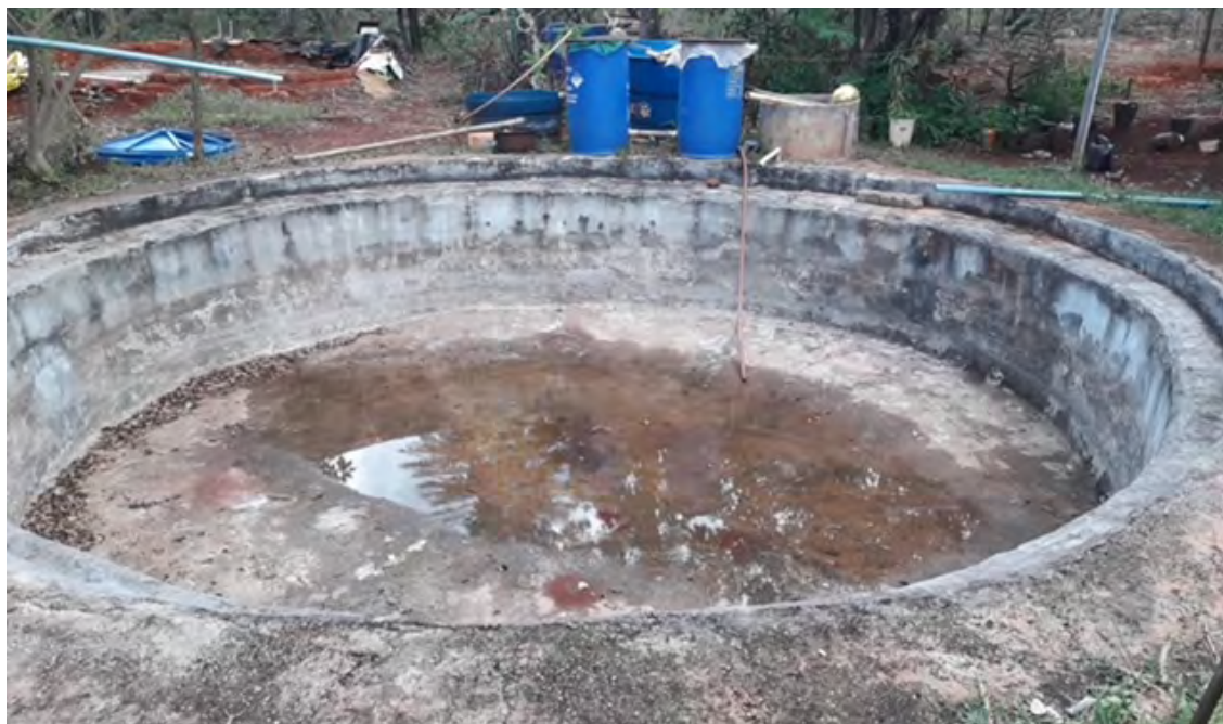
Figura 2. Reservatório da Parcela 16 - tanque escavado e revestido em ferrocimento Foto de Acácio Machado, 2020
