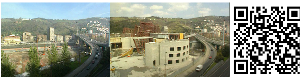
Construcción del Museo Guggenheim Bilbao, España, 2017.
