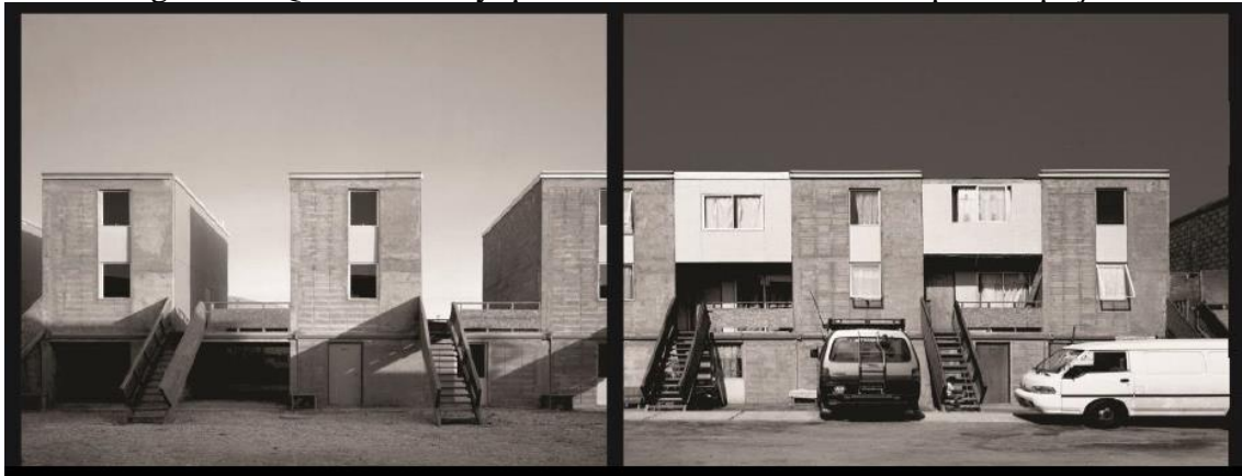
Figura 18: Quinta Monroy quando a obra foi finalizada x pós ocupação.
