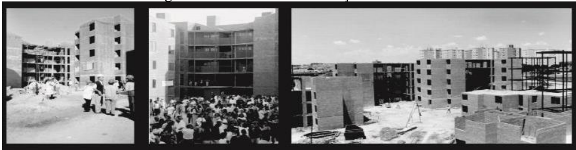
Figura 16: Detalhes da construção do bairro.
