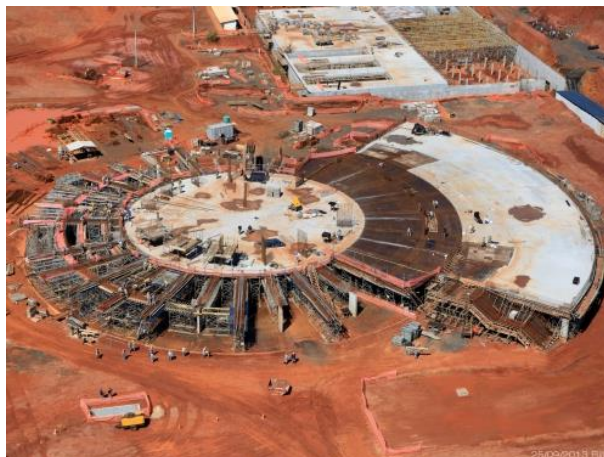
Foto retirada do site das futuras instalações da Unila.
