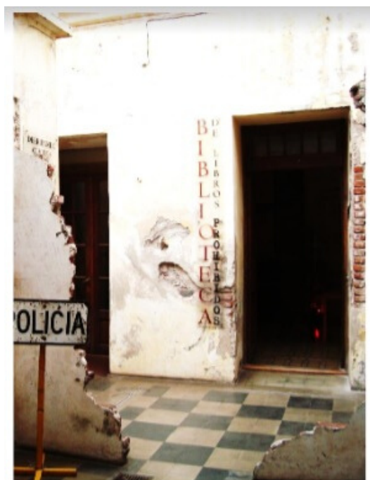
Muro derrubado para revelar espaços do ex-“D-2” (Foto: Elson Silva, Acervo pessoal)
