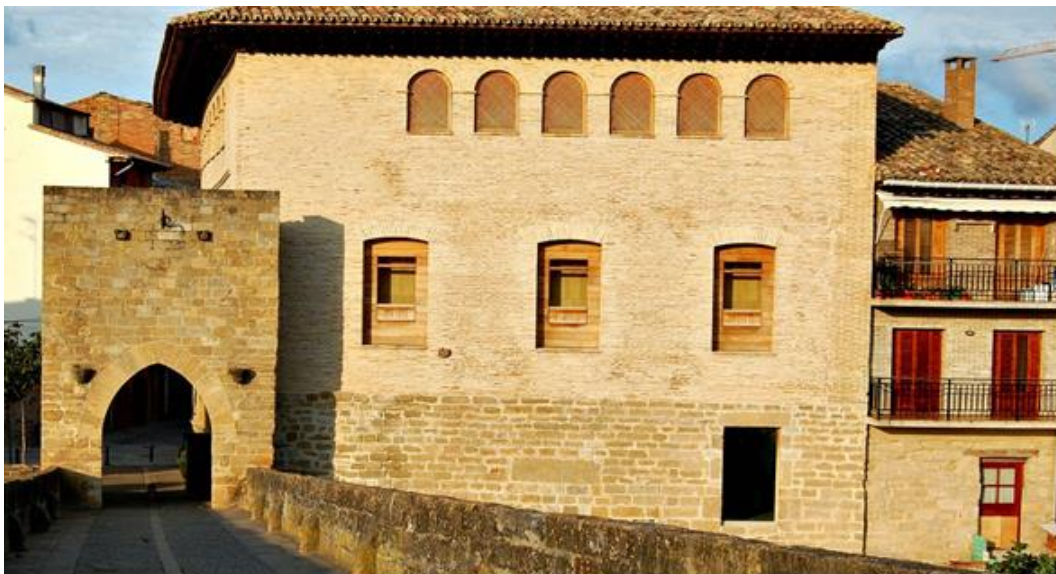
Figura 1. Casa del Vínculo, junto al Portal de la Carnicería, en el acceso desde el Puente Románico
